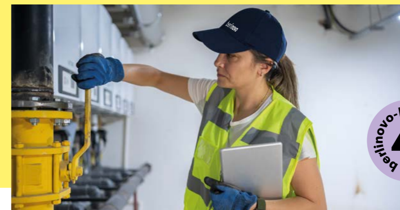
Moderne Heizanlagen bieten Sparpotenziale
