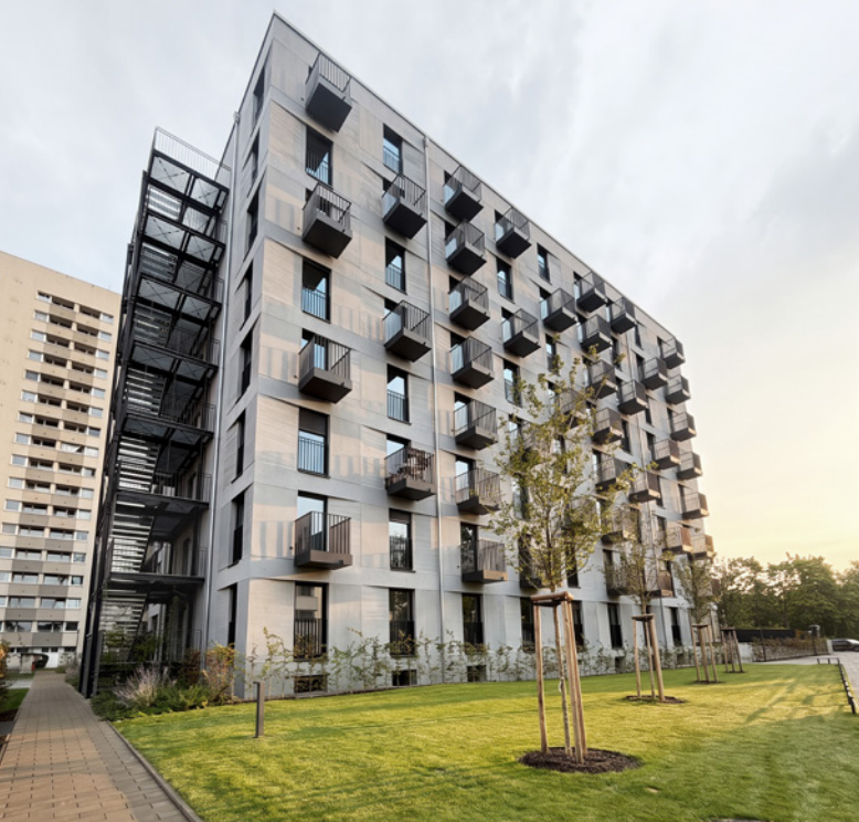
Der Neubau am Dröpkeweg in Neukölln: vorgefertigte Module, Holzfassade.
