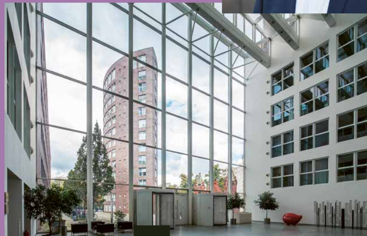
Rund 18.900 m 2 Bürofläche bietet das Büro- und Geschäftshaus Brunnenstraße in Berlin-Mitte.
